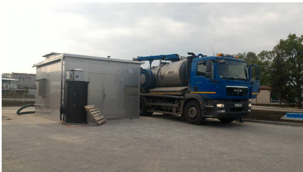
Obiekt nr 5 – stacja zlewna ścieków dowożonych.
